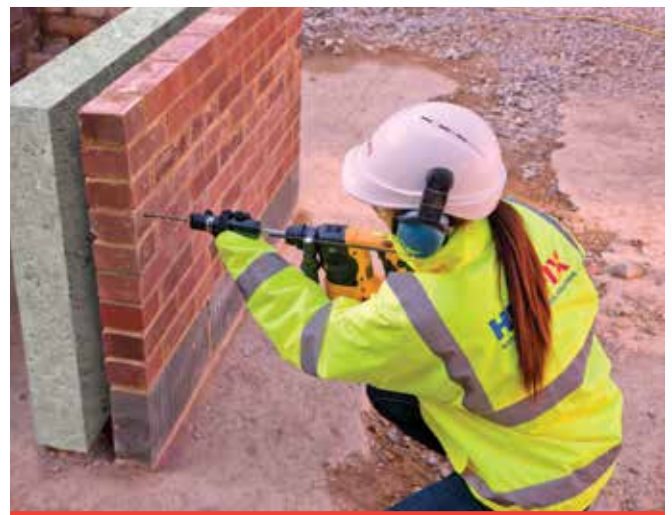
DryFix anker wordt met boor in gat gedreven
