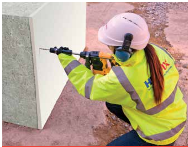
RenderPin wordt met boor in gat gedreven
