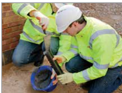
4. Controleer of de zuiger goed sluitend in de koker zit, overeenkomstig de aanwijzingen voor het voegpistool. Breng het mengsel direct na het roeren aan in de koker van het kitpistool
