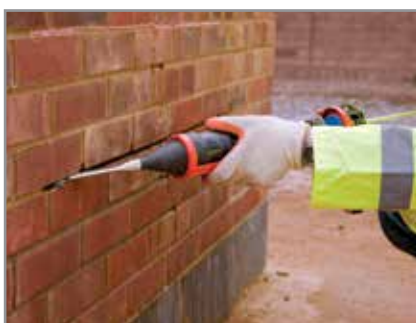
5. Spuit in één keer in de sleuf of opening. De typische gebruikstijd van het mengsel in de emmer is 2 uur; mits opnieuw wordt geroerd . De koker moet binnen 5 minuten worden geleegd. Als de insputting om welke reden dan ook wordt onderbroken, leeg dan de inhoud van de koker weer in de emmer en roer opnieuw totdat een glad, insputbaar mengsel is verkregen.
