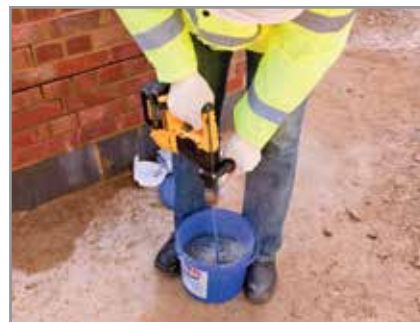
3. Roer grondig met een elektrische menger met mengschoepen. Meng niet met de hand, dit zal waarschijnlijk tot ongelijke resultaten leiden
