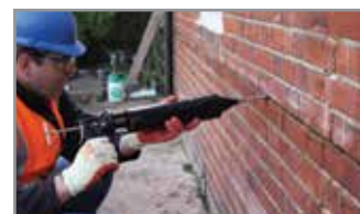
5. Breng opnieuw een ril HeliBond aan over de zichtbare HeliBar en eindig 12 mm van het oppervlak. 'Strijk' stevig in de sleuf met behulp van het Helibar voegijzer
