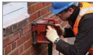
1. Schraap of frees sleuven uit in de lintvoegen, zoals gespecificeerd
