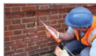
6. Voeg het mortelbed opnieuw en herstel de verticale scheuren met CrackBond TE
