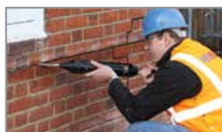
3. Gebruik het Helifix voegpistool om een ril HeliBond langs de achterkant van de sleuf aan te brengen
