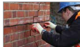
4. Gebruik het Helibar voegijzer om één HeliBar in de mortel te duwen om een goede dekking te verkrijgen. Herhaal vervolgens stap 3 en 4.
