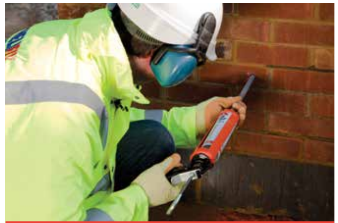
PolyPlus hars in buitenblad spuiten om de installatie van ResiTie te voltooien
